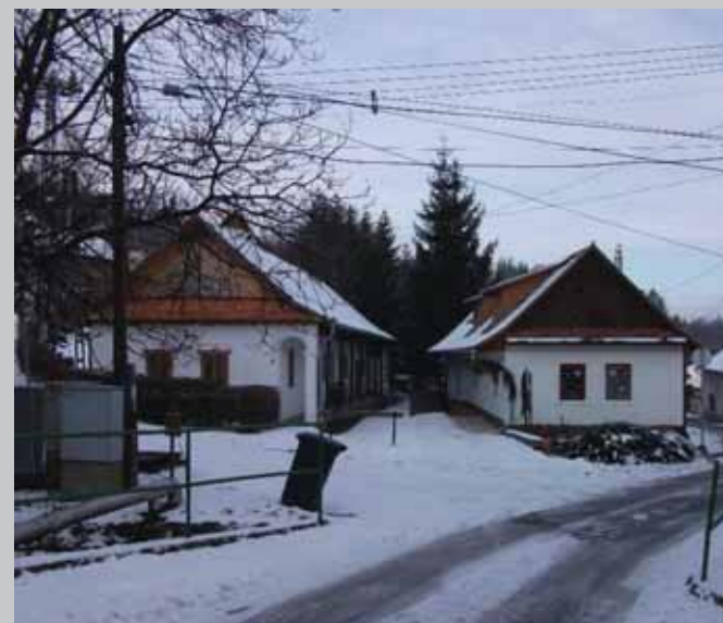
Mátrakeresztes, felújított karakteres, értékes népi lakóházak
