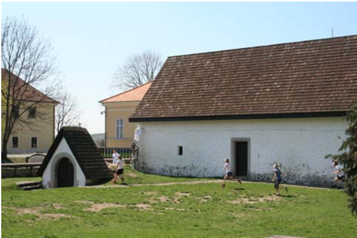
Az Oskolamester háza nyugati homlokzata a bejárattal és a rámpás pincelejáróval Fotó: Hír János
