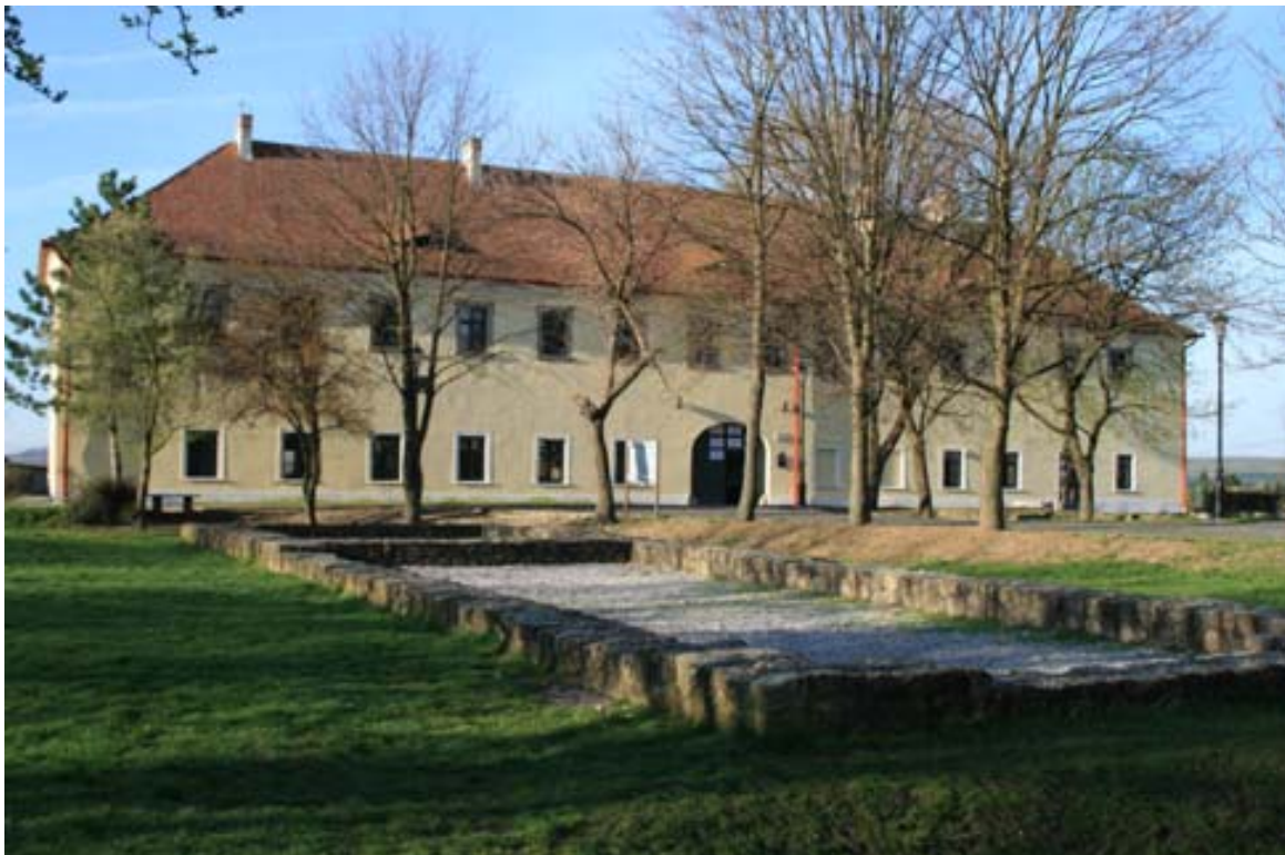
A barokk kolostorépület északi homlokzata előtérben a kovácsműhely alapjaival. Fotó: Hír János
